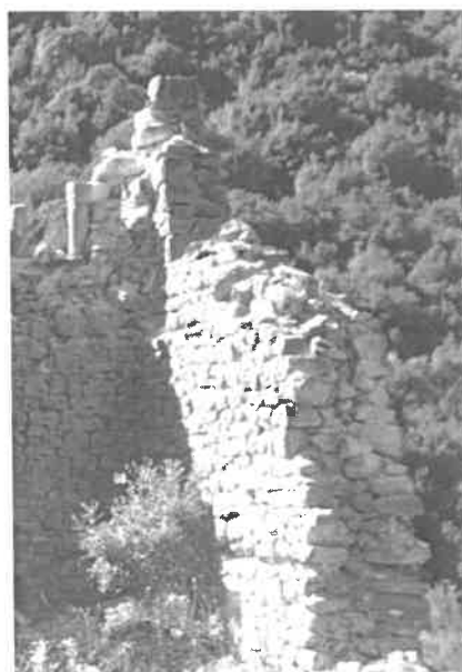
Εικόνα 10: Τρίστρωτη λιθοδομή του κτιρίου Γ
