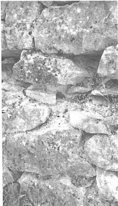
Εικόνα 27: Αποσάθρωση του συνδετικού κονιάματος των αρμών
