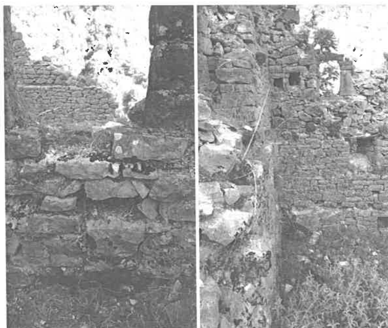
Εικόνα 30: Βιολογικές αναπτύξεις στην τοιχοποιία
