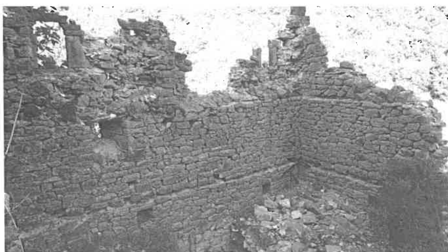
Εικόνα 11: Τα αποτυπώματα των ξυλοδεσιών και των ξύλινων δοκίδων του κτιρίου Γ
