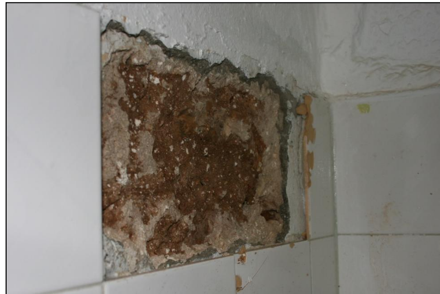
Εικ. 30. Δοκιμαστική τομή η οποία πραγματοποιήθηκε με την αφαίρεση σύγχρονου κεραμικού πλακιδίου από την τοιχοποιία του χώρου 1 ώστε να ανιχνευθεί η δομή την τοιχοποιίας του μνημείου. Κάτω από το μεταγενέστερα τσιμεντοκονιάμα, εντοπίστηκε το κονίαμα επικάλυψης και το κάτω από αυτό η αργολιθοδομή.
