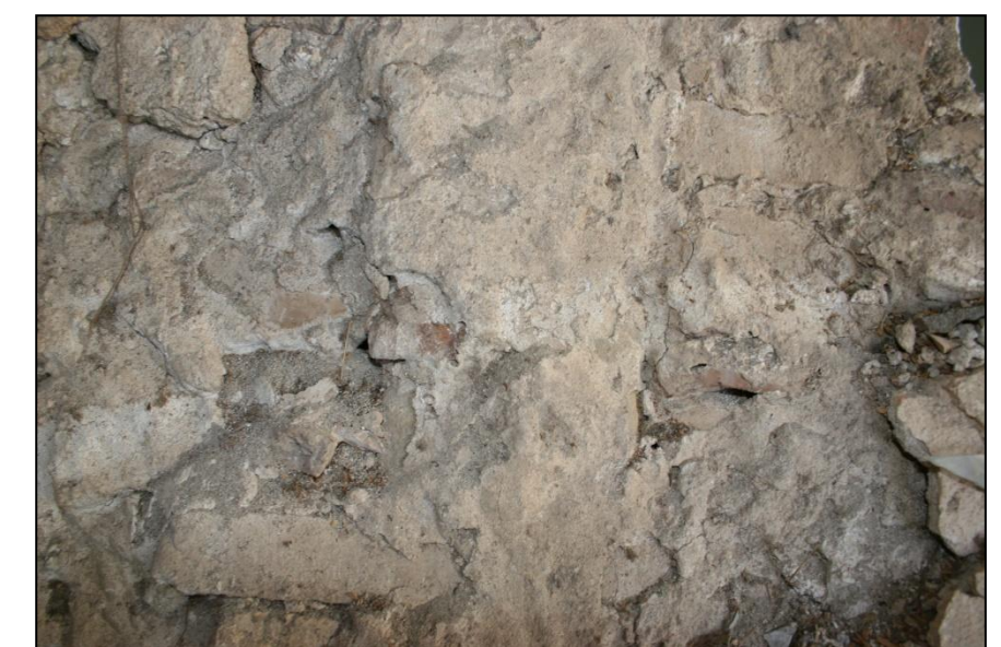
Εικ. 31. Με την αποδόμηση των σύγχρονων τσιμεντοκονιών μπορούμε να διακρίνουμε την πλινθοδομή των θολωτών κατασκευών.
