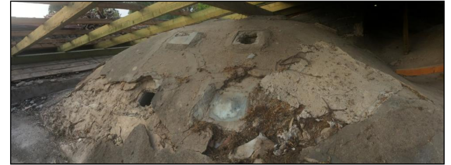
Εικ. 38. Σημείο της θολοδομίας όπου έχουν αποκολληθεί τα σύγχρονα κονιάματα από μπετόν και έχουν αποκαλυφθεί τα αρχαία. Διακρίνονται ξεκάθαρα οι σύγχρονες επεμβάσεις που επιβαρύνουν τη στέγαση.
