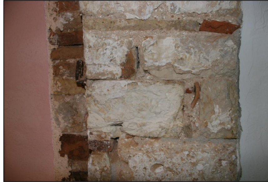
Εικ. 29. Τμήμα τοιχοποιίας του μνημείου όπου μπορούμε να διακρίνουμε την ημιλαξευτή αργολιθοδομή. Στο κονίαμα είναι διακριτά μικρά κεραμικά στοιχεία και βότσαλα. Επίσης έχουν γίνει μεταγενέστερες προσθήκες από οπτόπλινθους.
