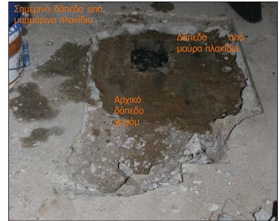
Εικ. 21. Δοκιμαστική τομή δαπέδου που πραγματοποιήθηκε στο χώρο 5
