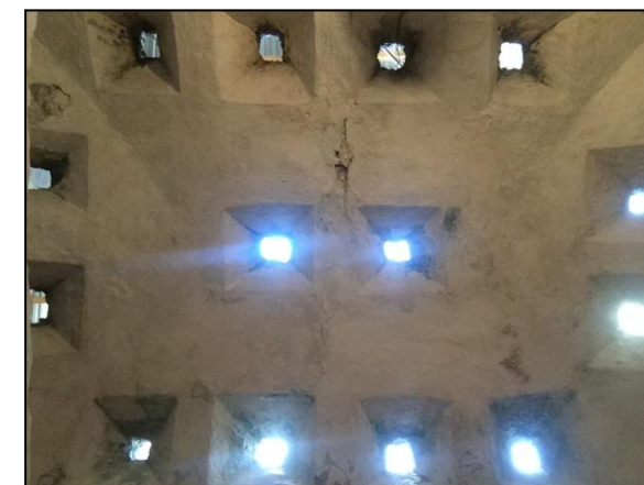
Εικ. 28. Διάταξη φωτιστικών θυρίδων στο χώρο 2.
