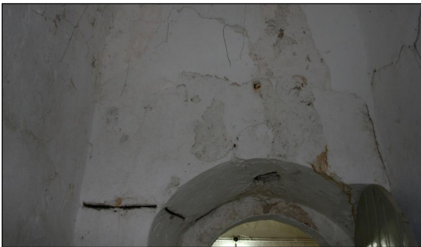
Εικ. 35. Οι ρηγματώσεις που εντοπίζονται αφορούν κυρίως τα μεταγενέστερα επιχρίσματα. (χώρος 5)
