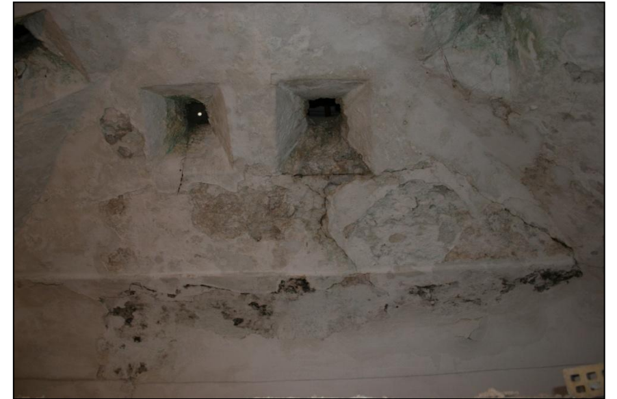
Εικ. 36. Γκριζόμαυρη κρούστα λόγω υγρασίας και αποκολλήσεις επιχρισμάτων κυρίως στους θόλους των χώρων. (χώρος 2)
