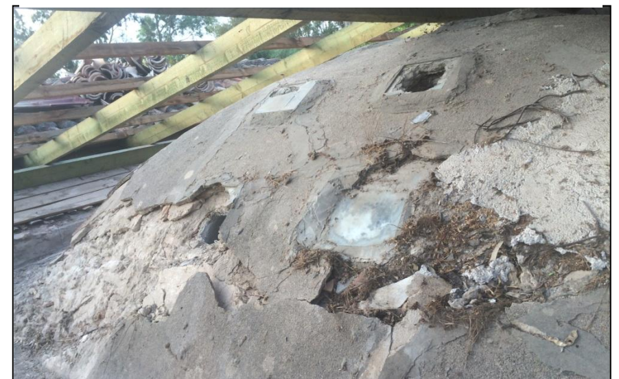
Εικ. 37. Ένα ακόμα σημείο παθογένεια του μνημείου αποτελεί η επικάλυψη των θόλων με τσιμεντοκονία η οποία έχει ρηγματώσει και αποδομηθεί σε αρκετά σημεία. Επιπλέον επιβαρύνει τη θολοδομία με επιπλέον φορτίο.
