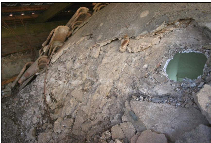
Εικ. 27. Επεμβάσεις από τσιμέντο που έχουν επικαλύψει τους θόλους και έχουν προκαλέσει παθογένειες στο μνημείο. Τα κεραμίδια αποτελούν μπάζα τα οποία απομακρύνθηκαν κατά τις εργασίες καθαρισμού τις στέγης γιατί δεν ανήκαν στο μνημείο.
