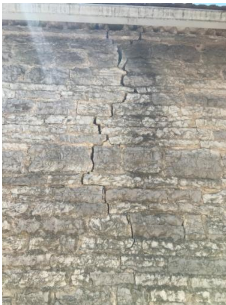
Ρηγματώσεις τοιχοποιίας
