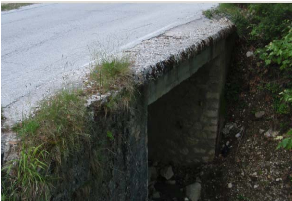
Εικόνα 5 Συμπαγής πλάκα φορέα καταστρώματος.
