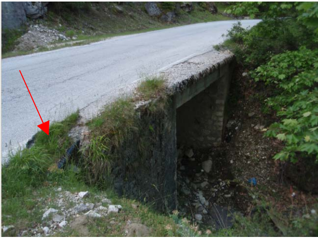
Εικόνα 8 Υποσκαφή μεταβατικού επιχώματος λόγω απουσίας πλευρικών υδραυλικών διαμορφώσεων αποστράγγισης.
