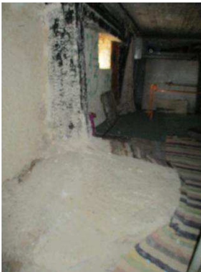
Άποψη του χώρου κάτωθεν της δυτικής αίθουσας (ισόγειο). Στο κτήριο έχουν τοποθετηθεί νεώτερα υποστυλώματα και δοκοί από οπλισμένο σκυρόδεμα, ενώ η νέα θεμελίωση κακής κατασκευής είναι επιφανειακή.
