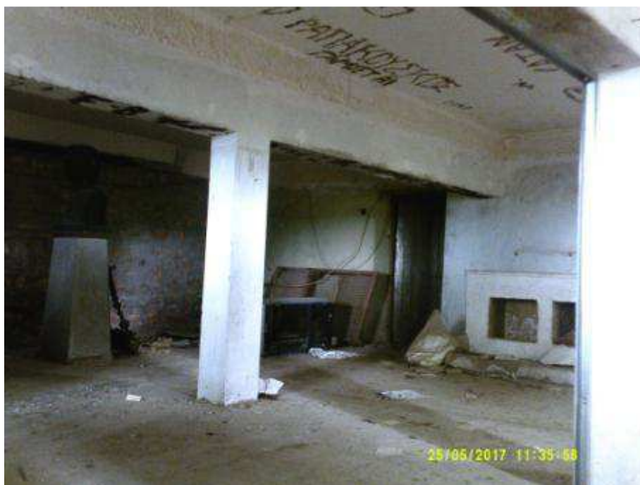
Άποψη του ενιαίου χώρου της προσθήκης (ισόγειο). Διακρίνονται οι νεώτερες επεμβάσεις από οπλισμένο σκυρόδεμα και συγκεκριμένα τα υποστυλώματα, οι δοκοί καθώς και η πλάκα του ορόφου. Στον τοίχο που εφάπτεται η προσθήκη με το αρχικό κτήριο έχει γίνει νεώτερη αρμολόγηση.
