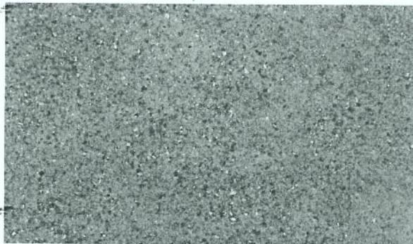
Εικόνα 9. Λεπτομέρεια επίστρωσης με χυτό δάπεδο από τσιμεντοκονίαμα
