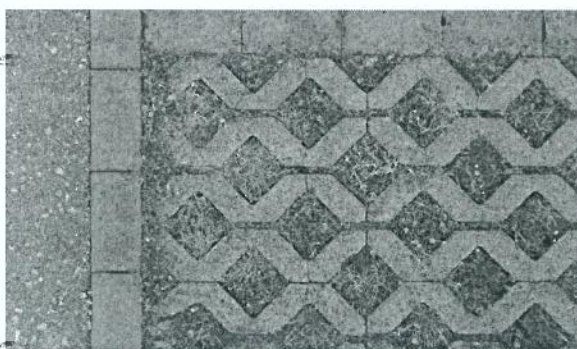
Εικόνα 8. Λεπτομέρεια επίστρωσης με διάτρητο κυβόλιθο και διαμόρφωση περιγραμμάτων με συμπαγή κυβόλιθο
