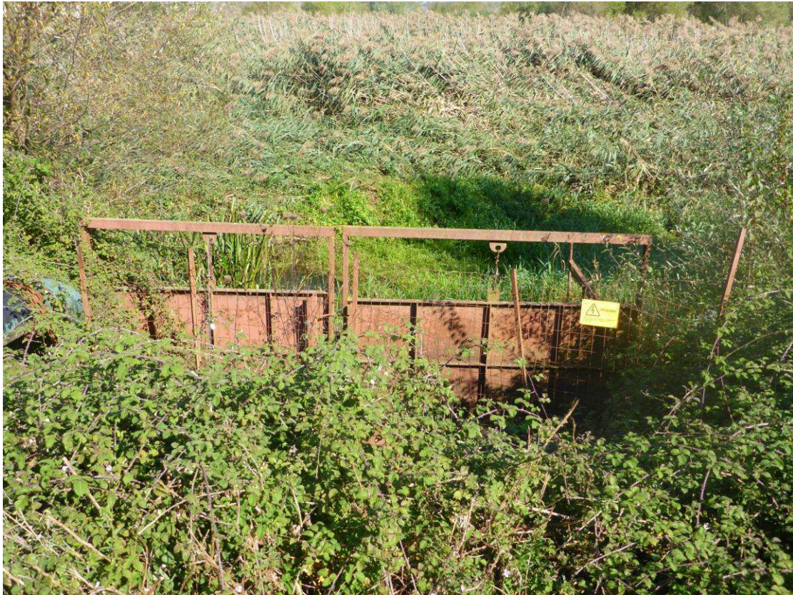
Φωτογραφία 7: Υφιστάμενο θυρόφραγμα πλησίον του αναχώματος
