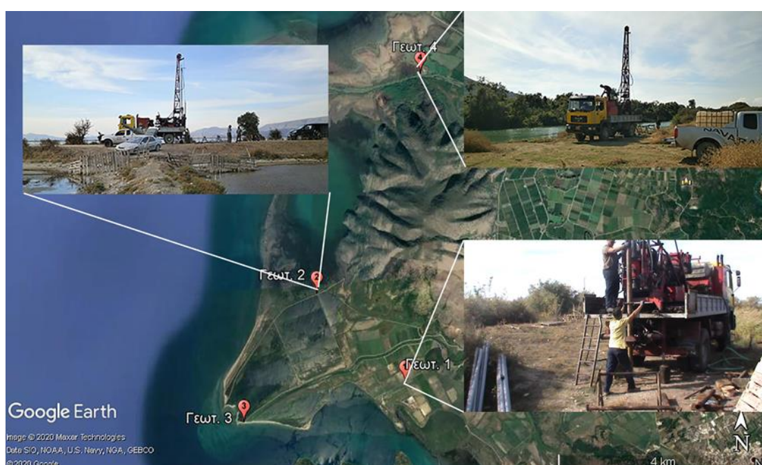
Εικόνα 17: Δορυφορική εικόνα της περιοχής μελέτης, όπου έχουν αποτυπωθεί τα σημεία των γεωτρήσεων. Στις εσωτερικές φωτογραφίες παρουσιάζονται στιγμιότυπα κατά την εκτέλεση των γεωτρητικών εργασιών.
