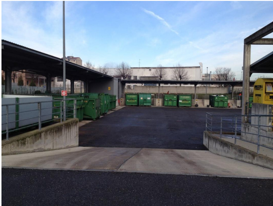
Εικόνα 25: Γενική άποψη ασφαλτοστρωμένης πλατείας
