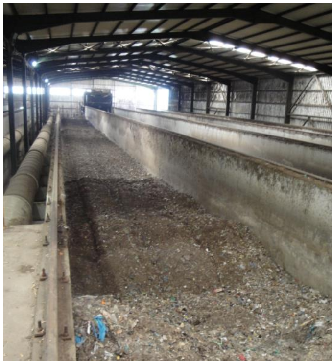
Εικόνα 14: Σύστημα κομποστοποίησης σε κανάλια
