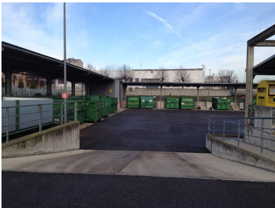
Εικόνα 25: Γενική άποψη ασφαλτοστρωμένης πλατείας
